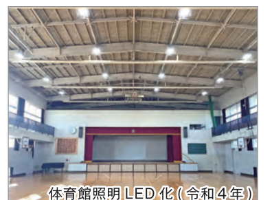
体育館照明LED化(令和4年)
