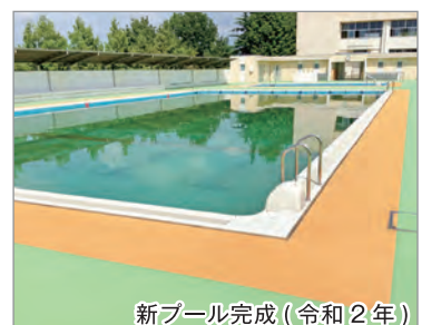
新プール完成(令和2年)
